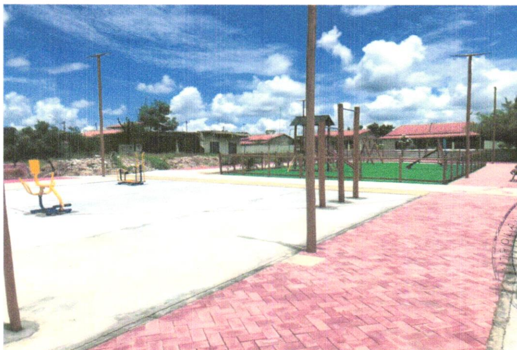
FOTO 06 – Fornecimento e assentamento de Multiexercitador 7x1
