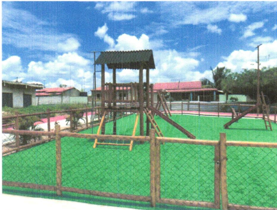
FOTO 07 – Fornecimento e assentamento de Casinha do Tarzan em eucalipto tratado, com pórtico de um balanço
