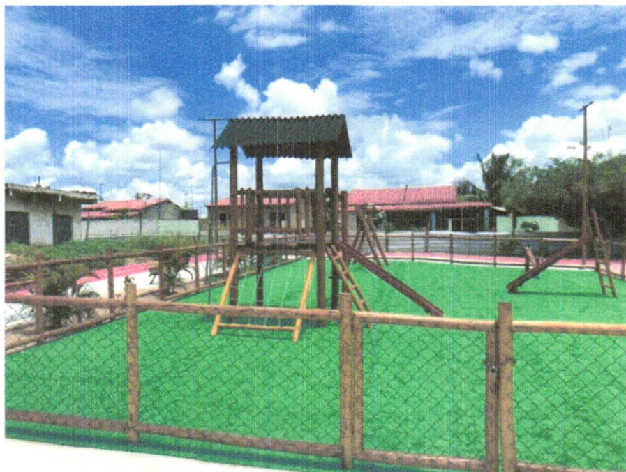
FOTO 07 – Fornecimento e assentamento de Casinha do Tarzan em eucalipto tratado, com prtico de um balano
