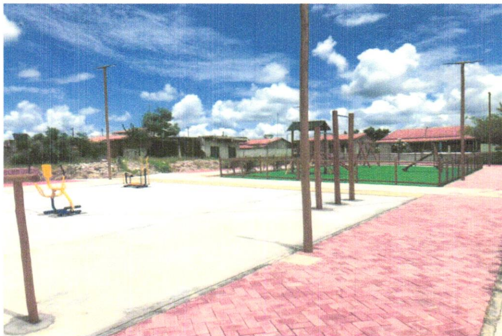
FOTO 05 – Fornecimento e assentamento de barra de apoio de 02 níveis em eucalipto tratado
