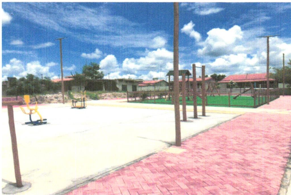
FOTO 05 – Fornecimento e assentamento de barra de apoio de 02 níveis em eucalipto tratado
