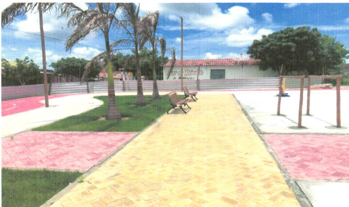
Foto 09 - Pavimentação em bloco de concreto vibroprensado, intertravado, colorido, 10x20cm, e=6cm, 46un/m 2 , NBR9781, Fck(min)=35MPa, sob coxim areia grossa compactada c/ placa vibratória, e(comp.)=6cm, rejuntado c/ areia fina
