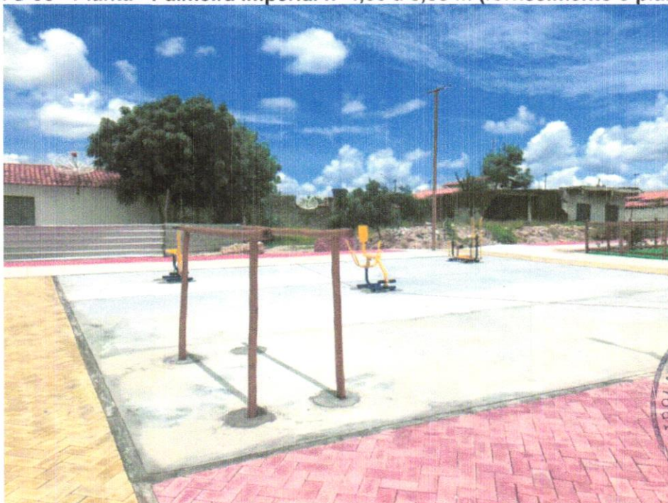
FOTO 04 - Fornecimento e assentamento de barra paralela em eucalipto tratado (L=2,5, H= 1,30)M
