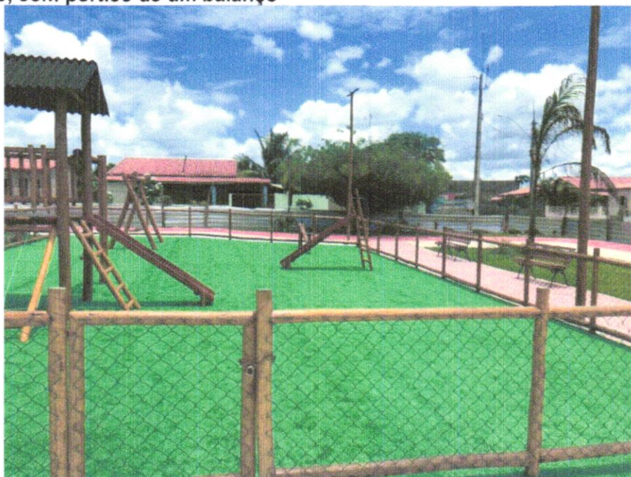
FOTO 08 – Fornecimento e assentamento de Escorregador em fibra com escada em eucalipto tratado, Fornecimento e assentamento de Balano em eucalipto tratado e Fornecimento e assentamento de Gangorra em eucalipto tratado
